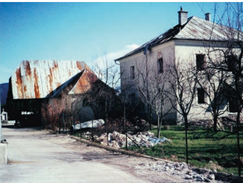
Alter Pfarrhof vor dem Abriss
