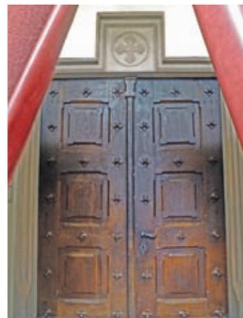
**In die schwere, zweiflügelige Eichtüre wurden 6 Kassetten eingearbeitet und 35 sternförmigen Holznägeln appliziert.**
